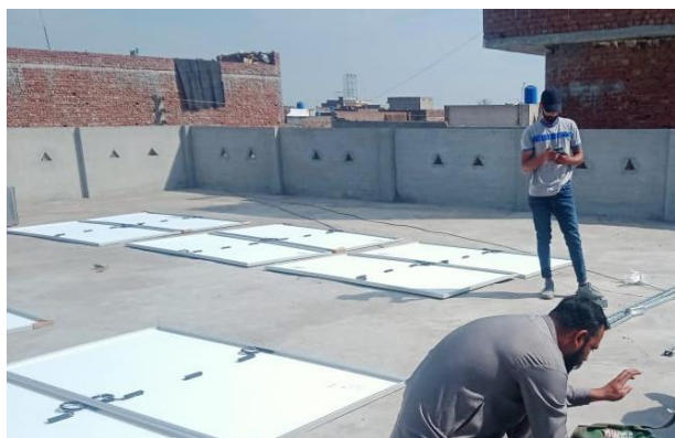
de dakrand is verhoogd ter bescherming van de panelen
